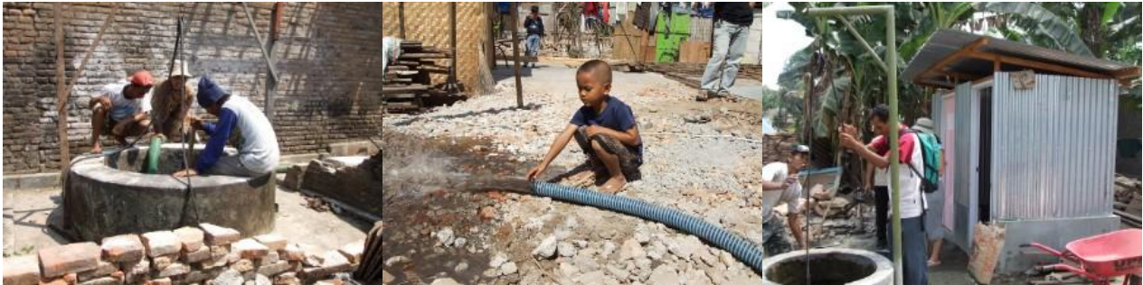
図7. 井戸の修復の様子 (左からポンプで泥を吸い出しているところ、吐き出された泥水、支柱や排水溝の整備)
