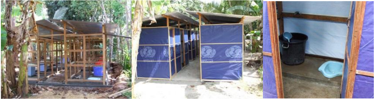
図5. 第1段階として建設した10部屋からなる仮設MCK(左から建設中、完成したもの、MCK内部)
