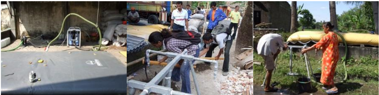
図8. 浄水の供給の様子 (左から浄化した水をバッグに入れているところ、バッグの設置作業、水を汲みに来た住民)
