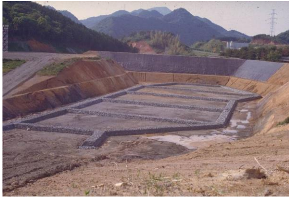
国内における典型的な準好気性埋立構造
